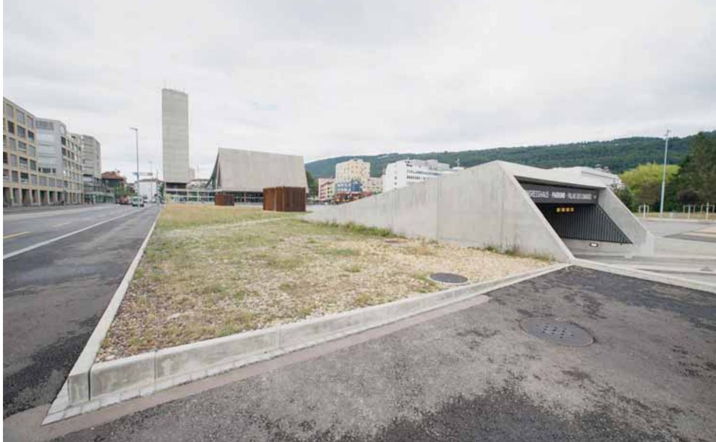
Une fois entourée d'un enclos, cette friche va-t-elle vraiment se transformer en place de jeu prisée des enfants? PS. JAGGI
